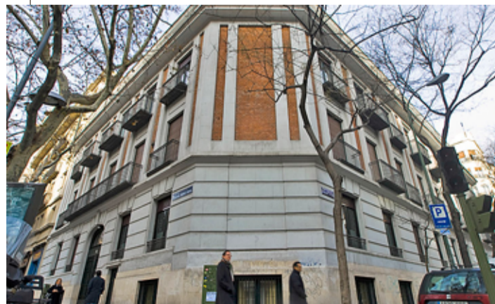
100 MILLONES. La fundación tendrá su sede en este edificio en el centro de Madrid. Tiene otros inmuebles, cercanos a la Castellana y a la plaza del Dos de Mayo.
